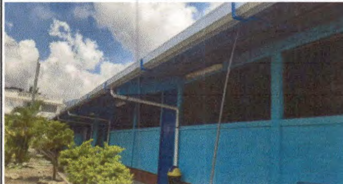
Foto 8: Sustitución de canal de metal
