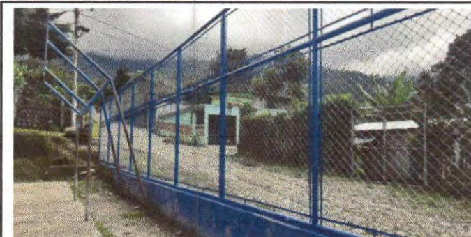
Foto 12: Reparación de tubo hg y malla galvanizada
