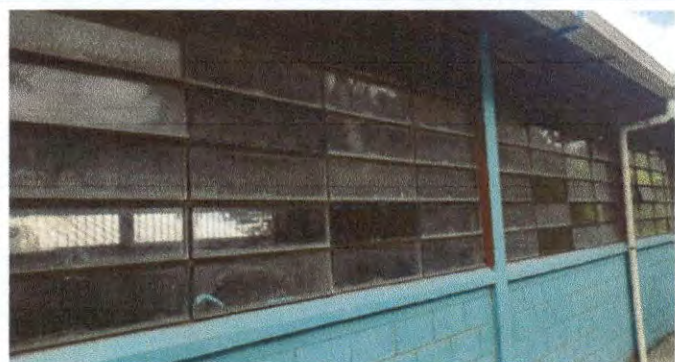
Foto 7: Sustitución de vidrios
