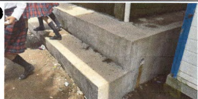
Foto 11: Reparación de muro de contención
