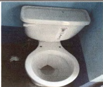
Foto 3: Sustitución de inodoro
