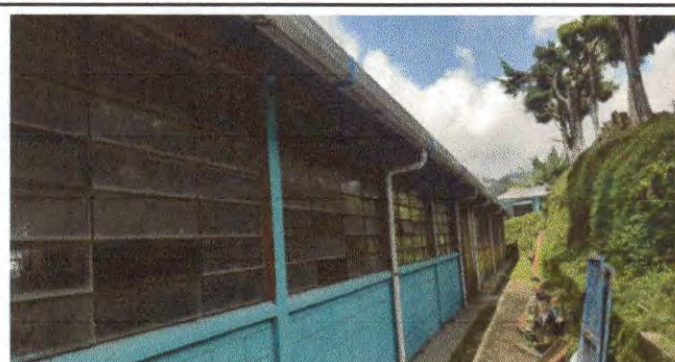
Foto 9: Reparación de bajada de agua pluvial, tubo PVC 3"
