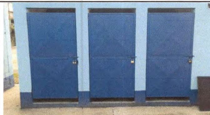
Foto 2: Sustitución de puerta en servicios sanitarios
