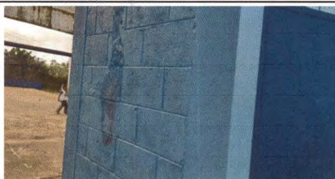
Foto 4: Sustitución de tubería línea principal
